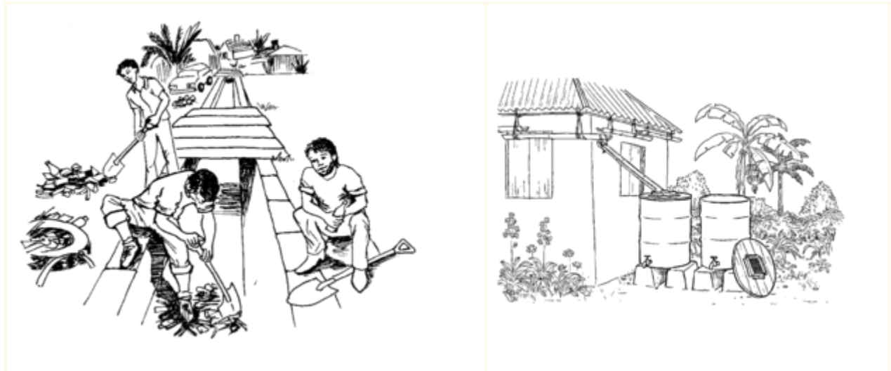
ការស្តារសម្ពាធលូទឹកជាប្រចាំ ជួយបង្ការជំនន់ និងជំងឺ។ ប្រែក្លាយទឹកភ្លៀងឱ្យទៅជាធនធានប្រចាំផ្ទះ។ រូបភាពទី៧៖ ការគ្រប់គ្រងទីជម្រាល
