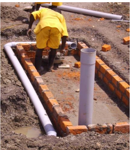
រូបភាព៖ ការរៀបចំប្រព័ន្ធបង្ហូររបស់អាងប្រមូលផល
