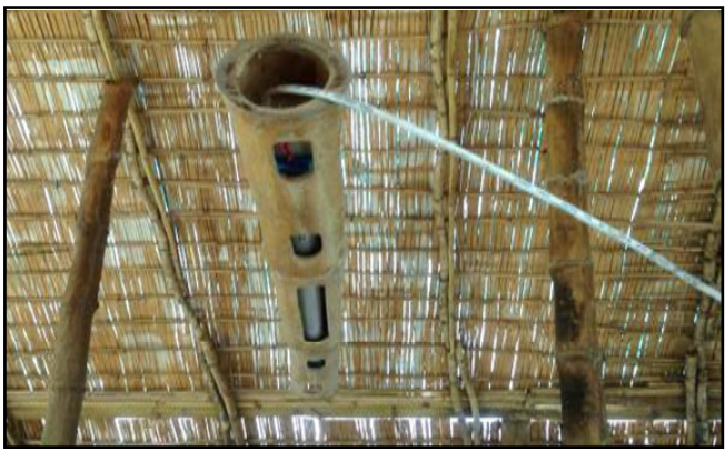
កំណាត់ដើមឫស្សីធ្វើជាប្រអប់អំពូលភ្លើងអគ្គិសនី
