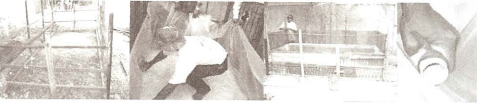
គ្រោងឆ្អឹងអាង ការពាសកម្រាលកៅស៊ូ ការពាសស្បែកមុង បំពង់បង្ហូរទឹកចេញ
