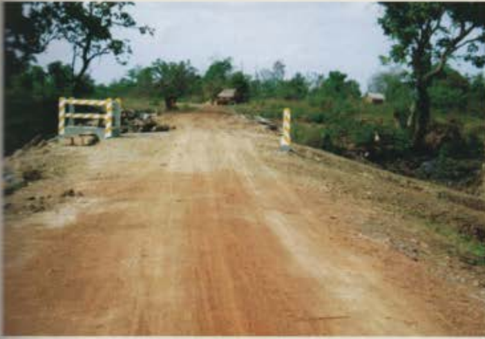
↪ ទំនប់ កោះ សុក្រី ក្រោយពេលជួសជុលរួច Koh Sokrom Dam after repaired
