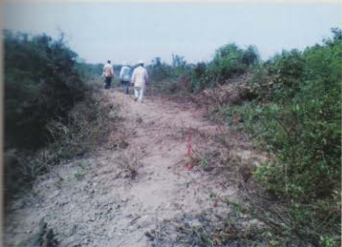
ទិដ្ឋភាពទំនប់តាឈានមុនពេលជួសជុល View Ta Chean Dam before rehabilitation
