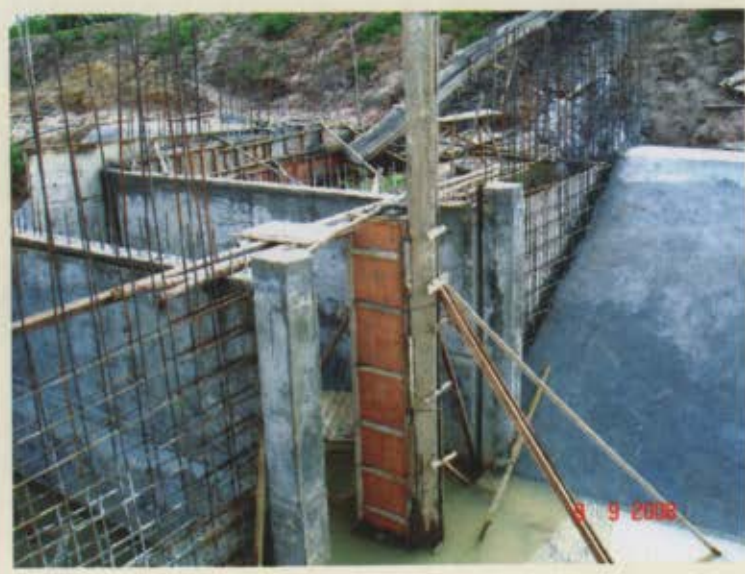
សកម្មភាពសាងសង់សំណង់ស្នាក់ទឹកទំនប់កំពង់ព្រៃ Activity construction check structure of the Kampong Chrey Dam
