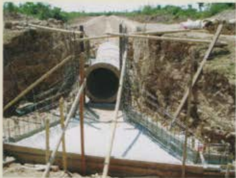
សកម្មភាពសាងសង់សំណង់ដោះទឹក និងសំណង់បញ្ចូលទឹកក្បាលប្រឡាយមេ
