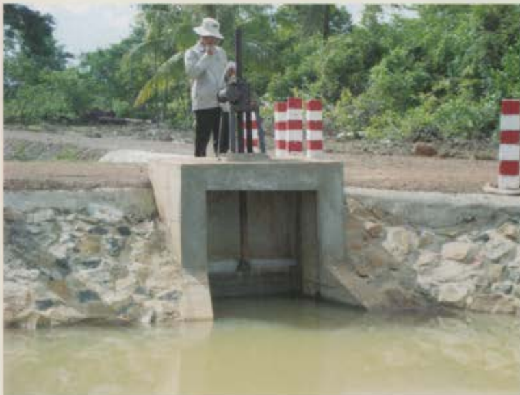
↪ សំណង់បញ្ជូនទឹកក្បាលប្រឡាយមេក្រោយពេលសាងសង់រួច Inlet structure on the head of main canal after construction
