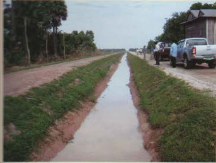
ទិដ្ឋភាពប្រឡាយរងក្រោយពេលស្តាររួច View secondary canal after rehabilitation
