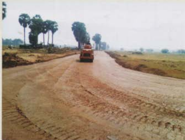
សកម្មភាពគ្រឿងចក្រកិនបង្ហាប់ខ្នងទំនប់ តា ឈាន Activity of machineries are compacting on the Ta Chean Dam
