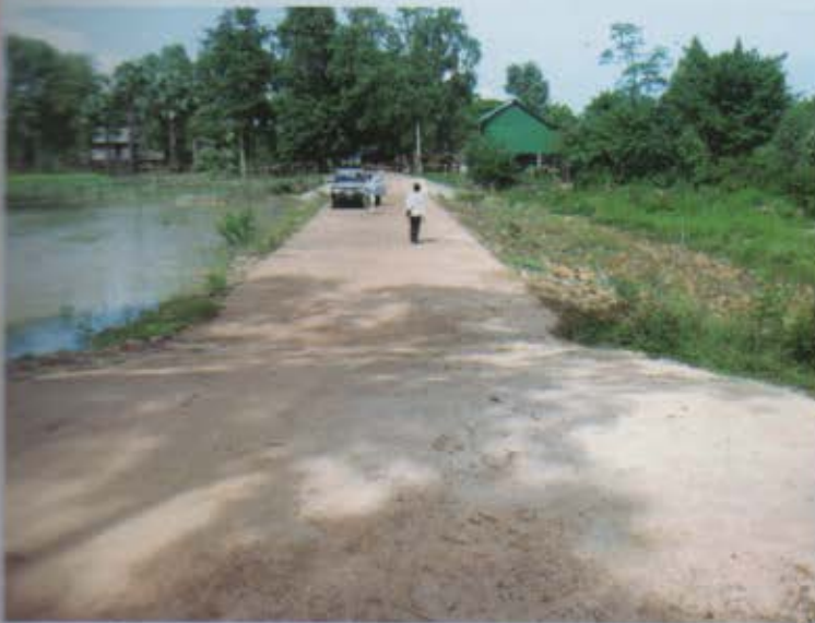
សំណង់បង្ហូរក្រោយពេលសាងសង់រួច Spillway structure after Construction
