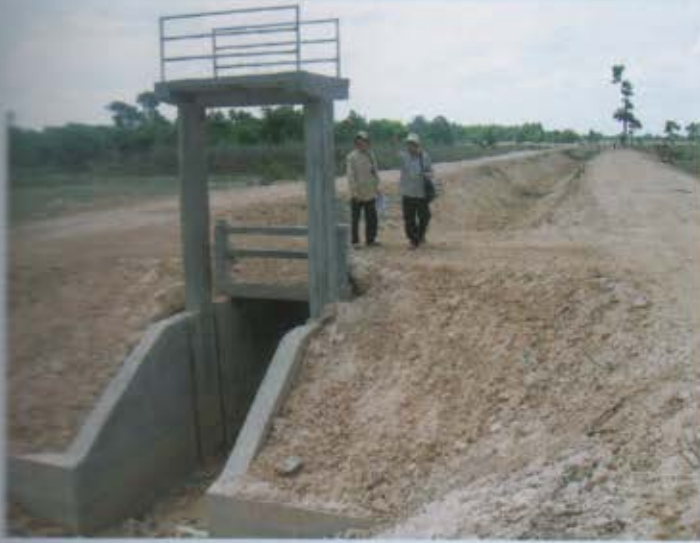
សំណង់ស្លាក់ទឹក ( ទ្វារ ១) ក្រោយពេលសាងសង់រួច Check structure (01 gates) after constructed
