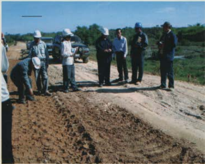
ឧត្តមរដ្ឋលេខាធិការ សំ សារិត ដឹកនាំគណៈប្រតិភូចុះត្រួតពិនិត្យការដ្ឋានកំពុងជួសជុលទំនប់ កោះ សុក្រំ H.E Sam Sarith, Secretary of state and officials visited the construction site of the Koh Sokrom Dam
