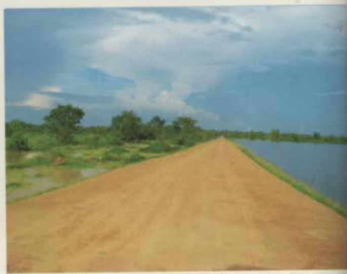
ទិដ្ឋភាព ទំនប់ អូរ ប្រង ក្រោយពេលជួសជុលរួច → The view O Prang Dam after repaired
