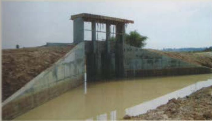
↪ សំណង់ដោះទឹកក្រោយពេលសាងសង់រួច Drainage structure after construction
