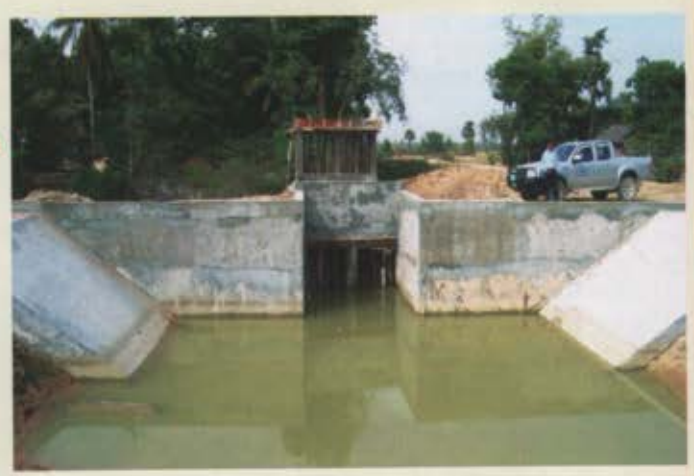
សំណង់បញ្ជូនទឹកក្បាលប្រឡាយមេក្រោយពេលសាងសង់រួច Intake structure in the head of the main canal after construction
