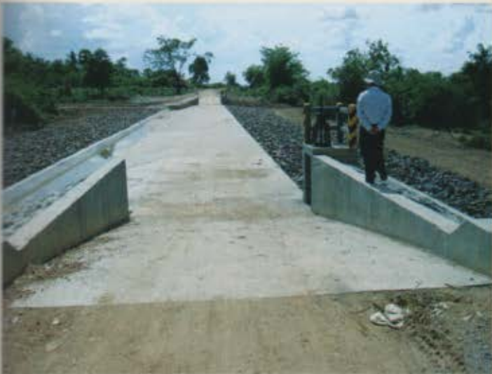
↪ សំណង់បង្ហូរ កោះ សុក្រី ក្រោយពេលសាងសង់រួច Spillway of the Koh Sokrom after construction
