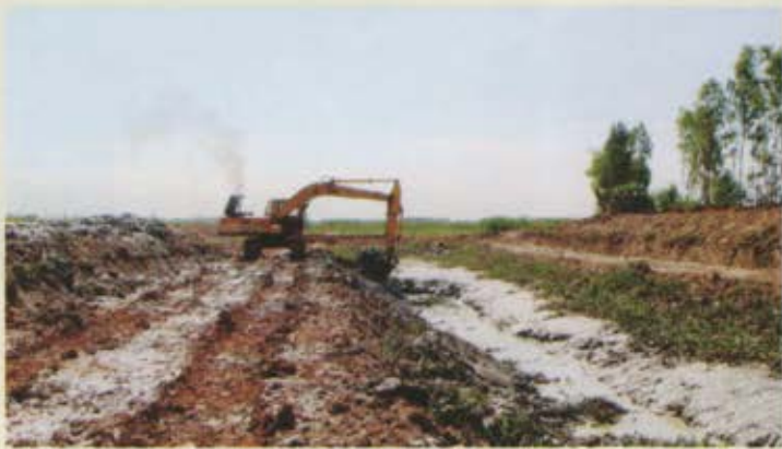
សកម្មភាពគ្រឿងចក្រស្តារប្រឡាយទាំទឹក តា ស្នាង Machinery activities rehabilitation intake canal Ta Saang Dam
