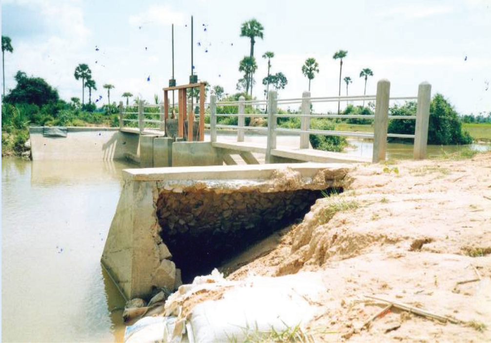
ជញ្ជាំងស្លាបត្រូវបានច្រោះដាច់ដោយសាចរន្តទឹក
