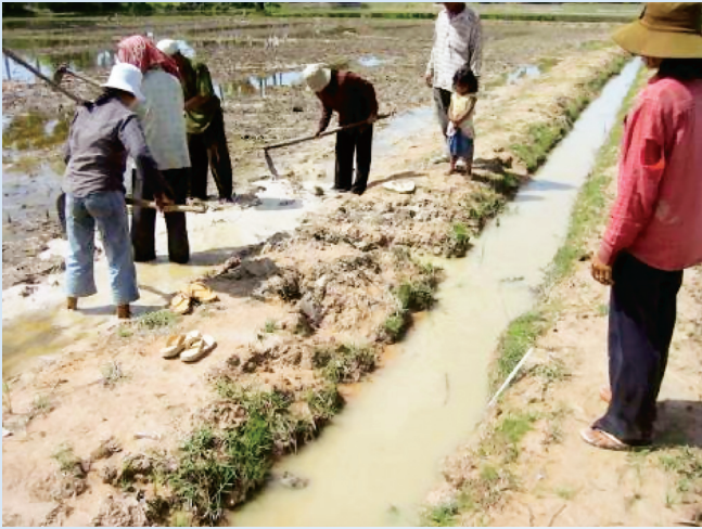
សកម្មភាពជួសជុល និង ដាក់បំពង់ជ័រវបង្ហូរទឹកចូលស្រែដើម្បីងាយស្រួលគ្រប់គ្រងទឹក និងថែរក្សាស្ថានភាពដើមរបស់ប្រឡាយ
