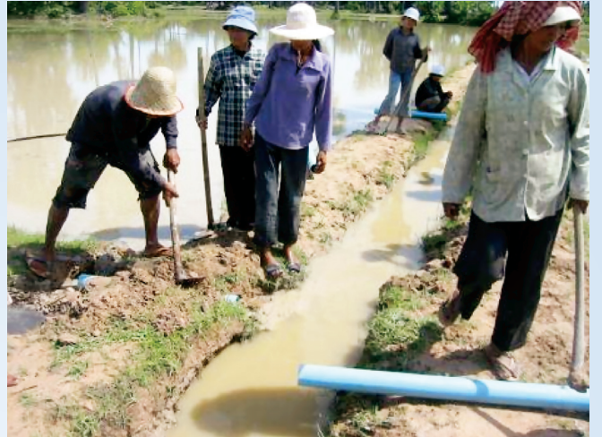
សកម្មភាពជួសជុល និង ដាក់បំពង់ជ័រវបង្ហូរទឹកចូលស្រែដើម្បីងាយស្រួលគ្រប់គ្រងទឹក និងថែរក្សាស្ថានភាពដើមរបស់ប្រឡាយ
