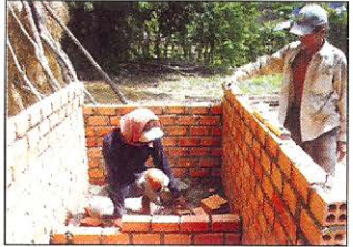
រូបភាពទី ១១៥: ការសាងសង់អាងធ្វើចំបើងផ្កាប់
