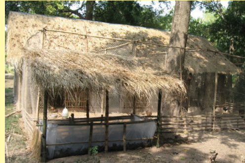
រូបទី៣២: ការធ្វើដំបូលការពារកំដៅ និង ភ្លៀង
